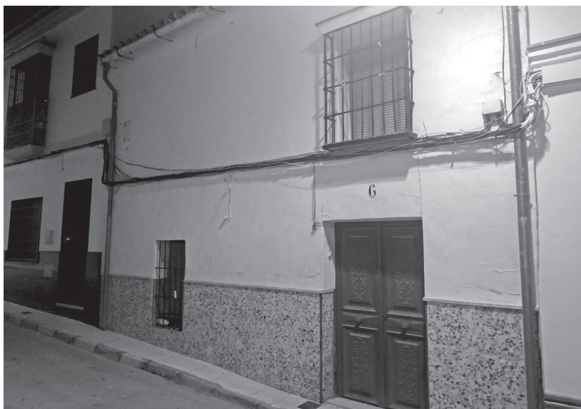
Estado actual de la casa de Tomás Jemes en c/ Lucenas, 6
